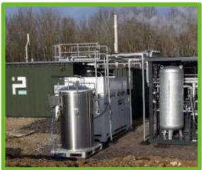
Sistema di cattura, liquefazione e stoccaggio di CO<sub>2</sub>, per uso finale da parte di terzi.
