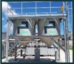
Sistema di trattamento Biogas (adsorbimento a Carboni Attivi)
