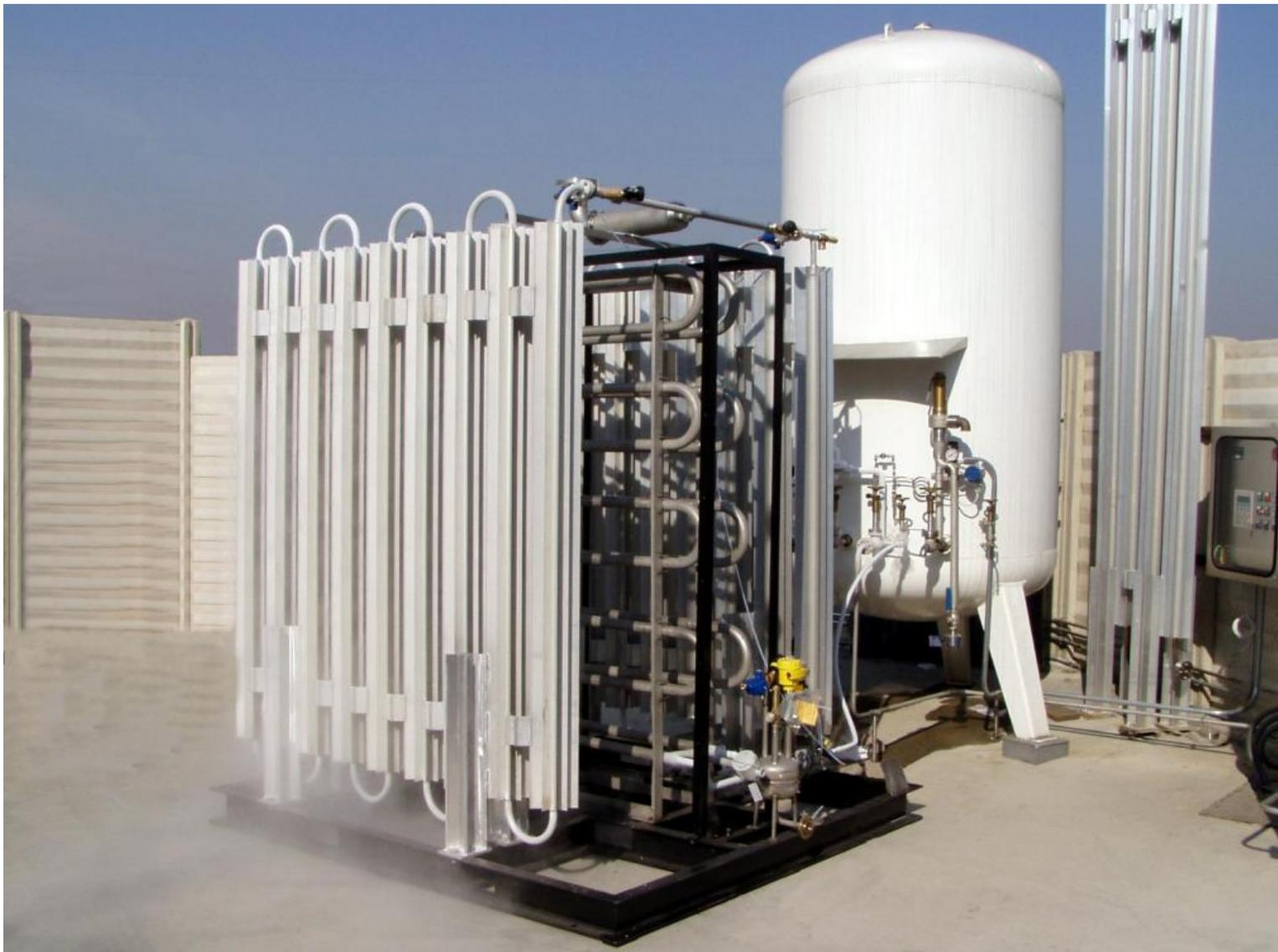
Progettazione e costruzione della “Cold Test Facility” per effettuare leak test criogenici con elio gassoso raffreddato a  $-196\text{ }^{\circ}\text{C}$  delle bobine PF per il progetto ITER (Cadarache – Francia)
