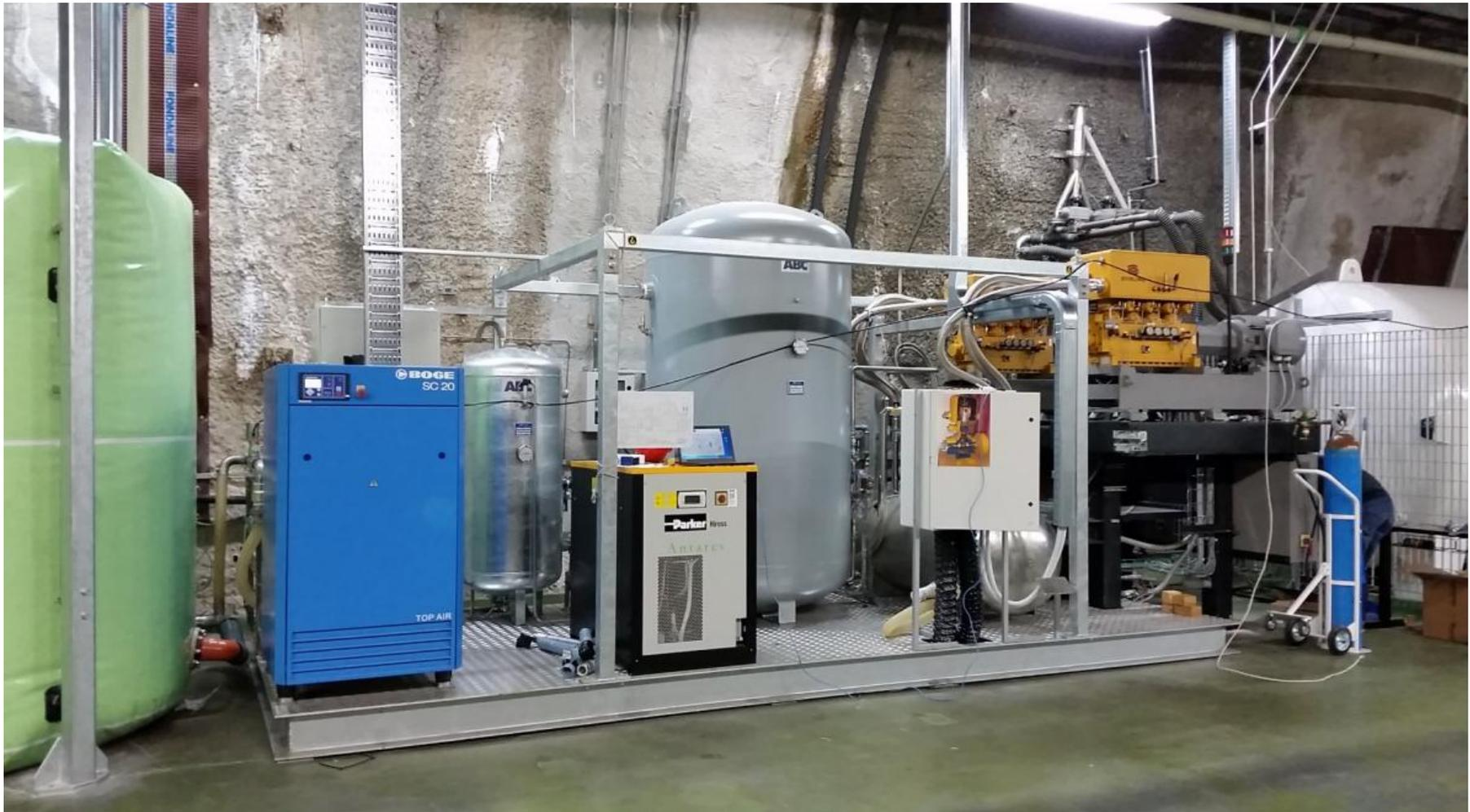
Impianto di condensazione metano utilizzando azoto liquido – Air Liquide
